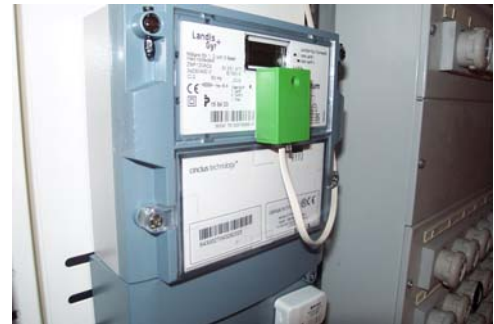
Ta bort skyddsfilmerna från fästkudden och sätt fast LED-Detektorn
